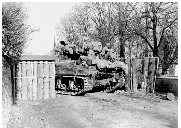
Einmarsch: Die Panzersperren bestanden in der Hauptsache aus Baumstämmen und waren mit Sand abgedichtet. Drei wurden – wie diese an der Eickumer Straße. – nicht verteidigt. ARCHIVFOTO: Dave Wallis
