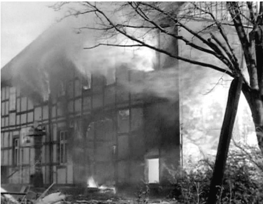
(2) Brand des alten Bahnhofs an der Kreuzung Beckendorfstraße – Jöllenbecker Straße
