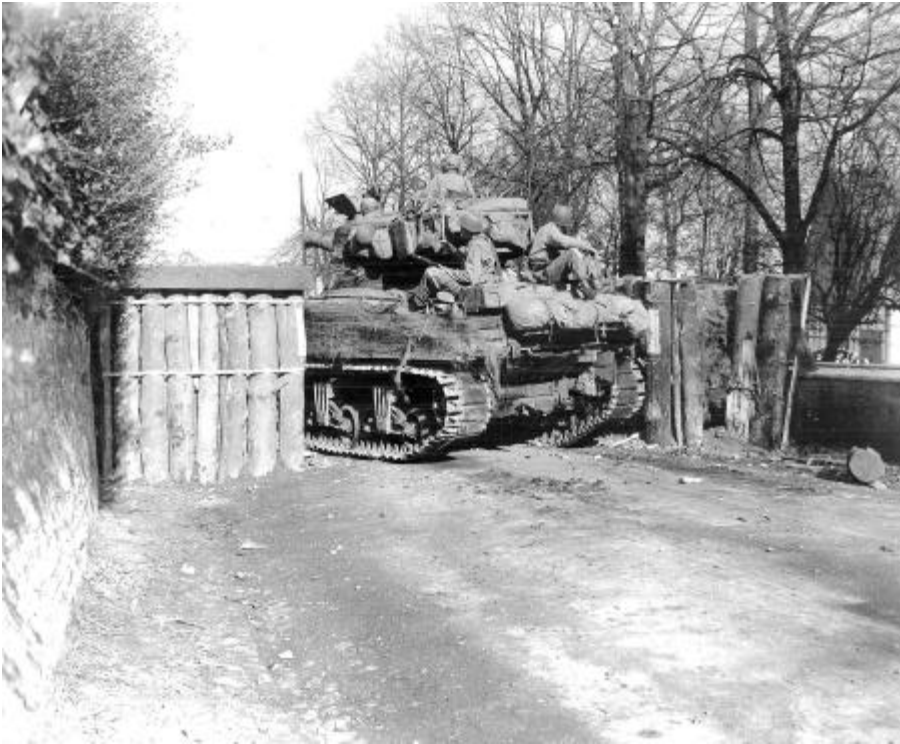
(7) Panzersperre auf der Eickumer Straße zwischen Friedhofsmauer und Hof Meier zu Jöllenbeck
